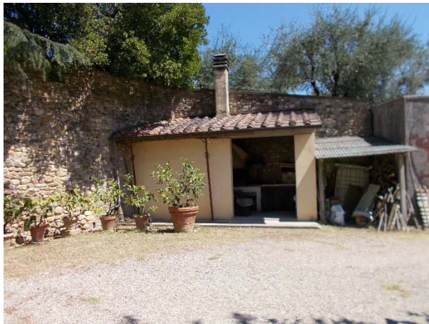
Foto effettuate durante il sopralluogo eseguito il 14/07/2020
